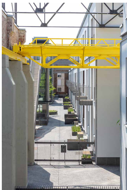
Abb. 13: »Innenraum« mit Bestandstützen und historischer Kranbahn
