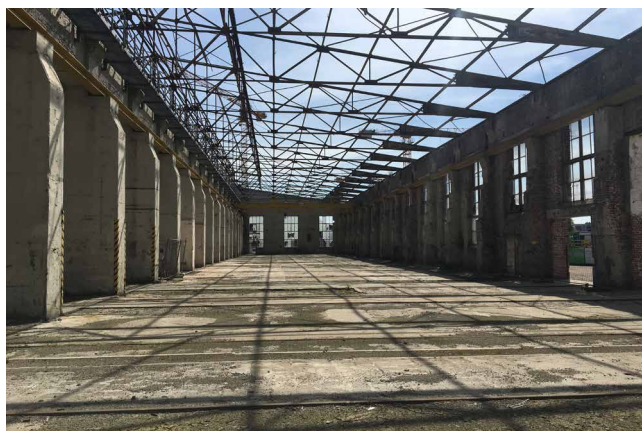
Abb. 4: Innenraum der Bestandshalle ohne Dacheindeckung
