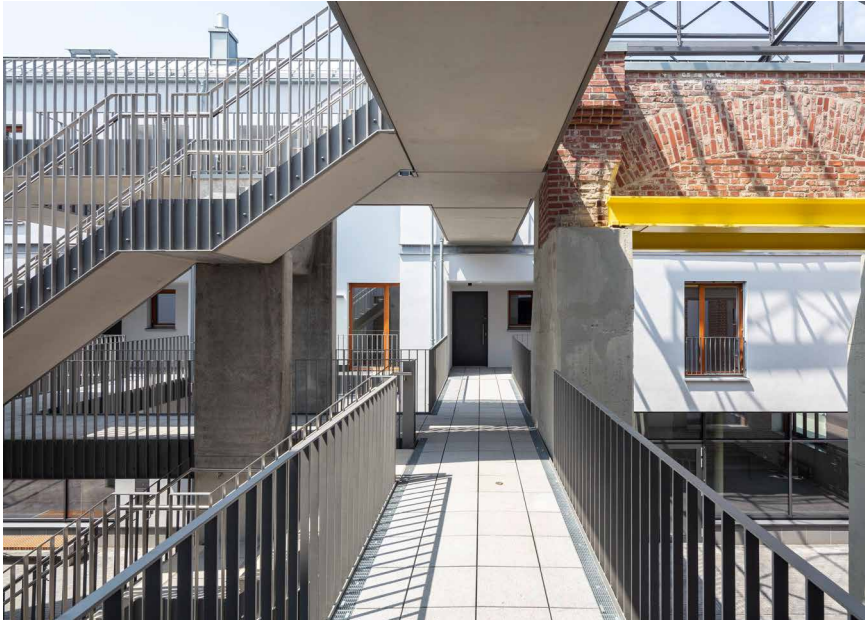
Abb. 17: Zweigeschossige Brückenkonstruktion mit Auflager in historischer Bestandsstütze
