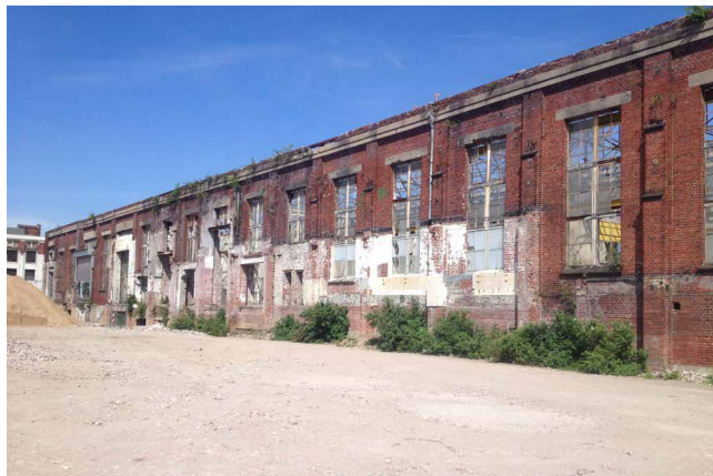
Abb. 3: Westfassade vor der Sanierung
