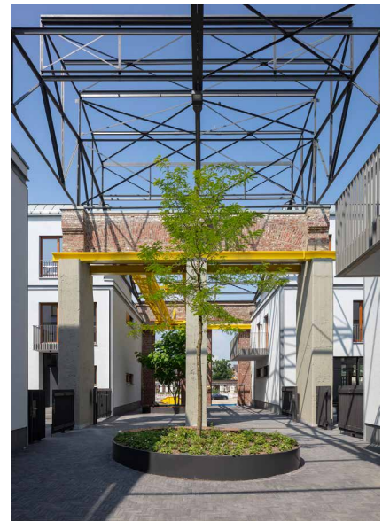
Abb. 12: Verbindung zum Luftschiff-Platz mit historischer Dachkonstruktion
