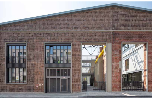
Abb. 11: Fassade des Nordgiebels mit Tiefgarageneinfahrt nach der Sanierung
